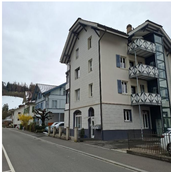
Abbildung 3 Haus Nydegger im heutigen Zustand mit Balkonanbau
